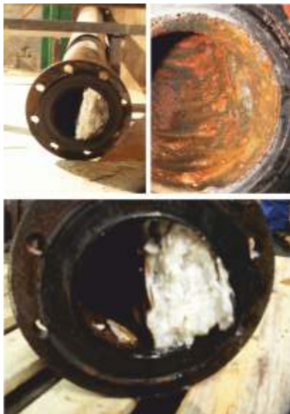
Querschnitte von Wasserleitungen, in denen das Wasser stagnierte (Foto Bublitz)
